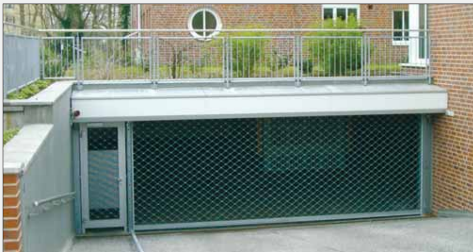
Rollgitter mit Nebentür in Tiefgarage.
